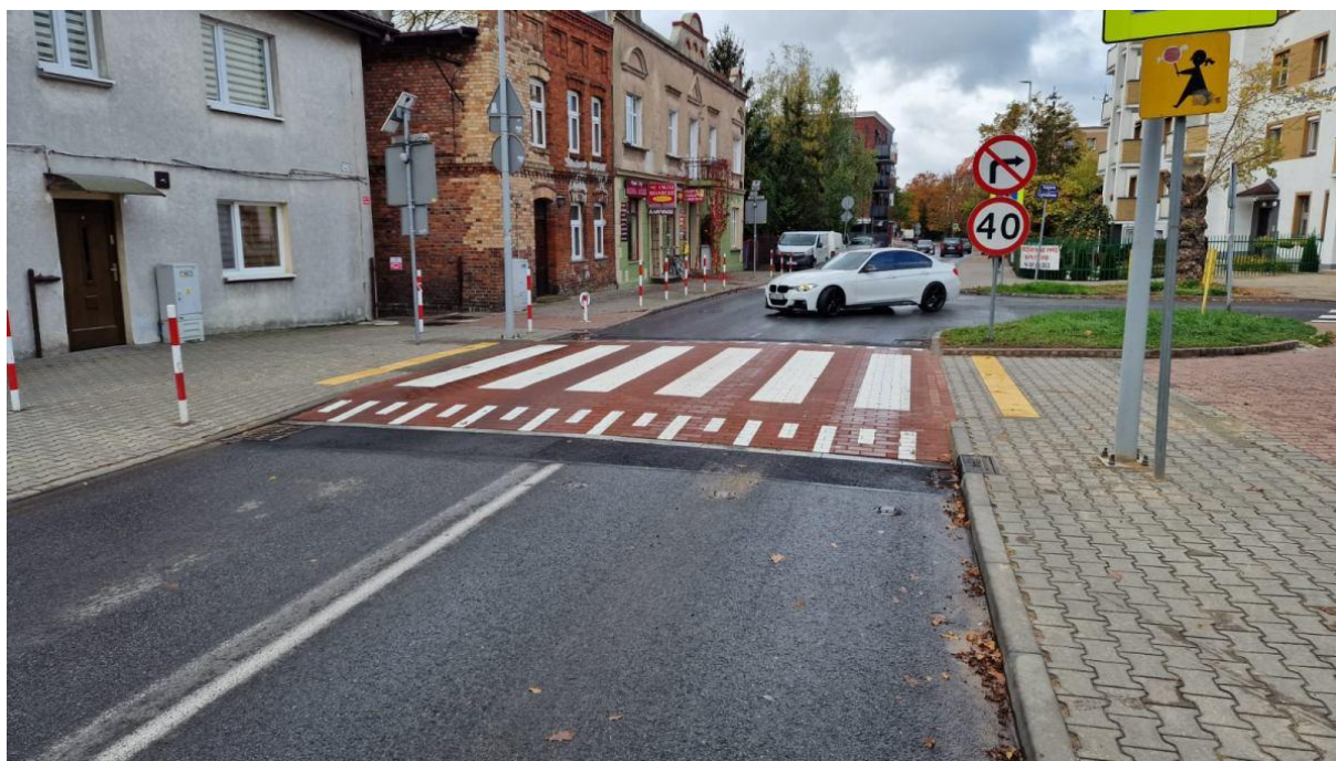
Fotografia 5.15 Wyniesione przejście dla pieszych w okolicach jednej ze szkół w Toruniu
